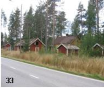
33 Rautatierakennusten ryhmää Asemanseudun pääsuoralla.
