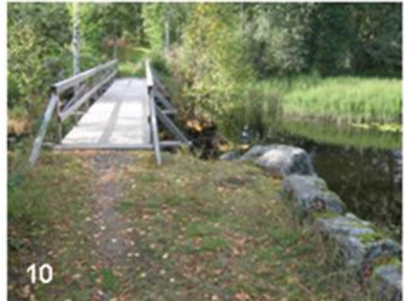
Vanha sillanpaikka on korvattu kevyellä sillalla Hannin Myllyn tuntumassa.
